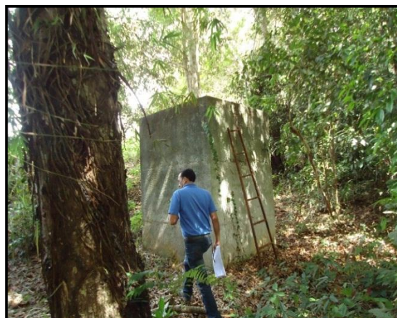
Foto IV.5.1-7: Talude de montante. Destaque para o monge, estrutura de concreto.
