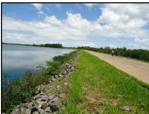
Foto IV.5.1-1: Talude de jusante e parte da área de inundação.
