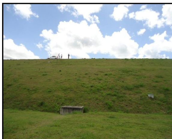
Foto IV.5.1-4: Talude de montante.
