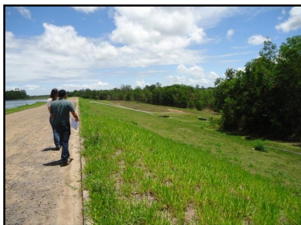
Foto IV.5.1-2: Talude de montante.
